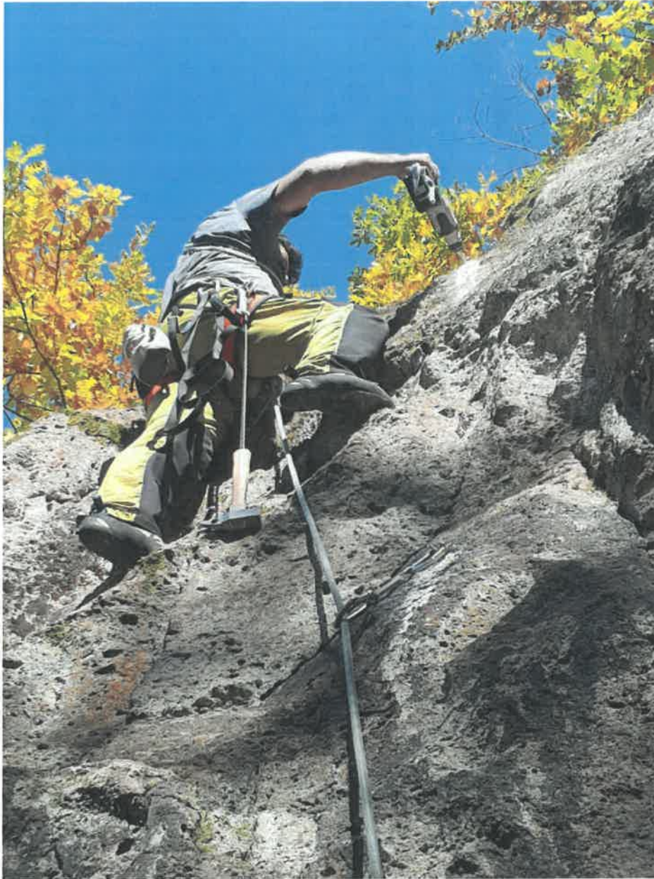
Rögzítőpontok kiépítése alsó biztosítással.
