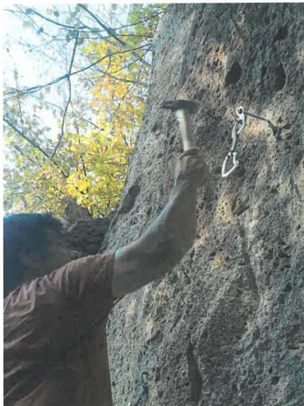
Biztosítópont elhelyezése a Megyer-hegyi Tengerszem Sziklamászó Iskolában
